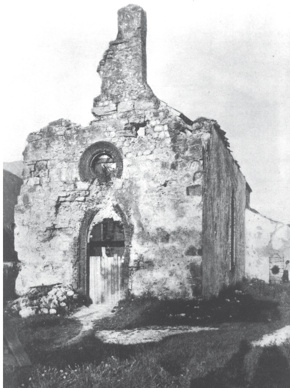
Sl. 13: Tolmin – Sv. Urh. Močno poškodovana cerkev med prvo svetovno vojno.
