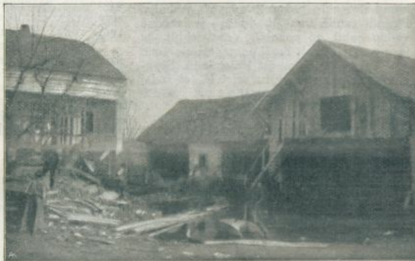
Katastrofa kolodvorske restavracije v Brežicah dne 15. februarja; nesreča je nastala vsled eksplozije karbidovega aparata. Novi del hiše, ki je bil pred nekaterimi leti prizidan, je popolnoma porušen — ostal je kupl šute, železne traverze so zvite, kakor bi bile iz papirja. Pokopalo je tudi baje pet oseb, med njimi gospoda Volčanška samega. Pok se je slišal več kilometrov daleč, kakor da bi kdo s topom ustrelil. Vzrok je najbrž voda, ki je prišla v klet, kjer je bil postavljen aparat.
