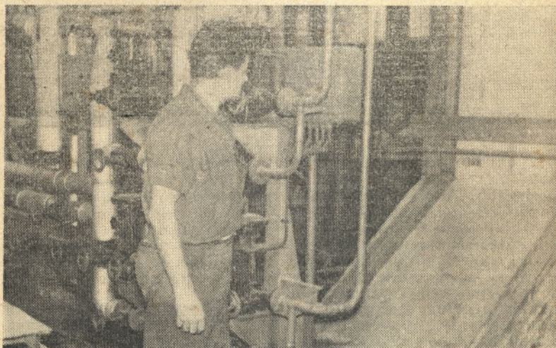
Kontrola gasilnih naprav na pečeh tov. Kirhmajer
