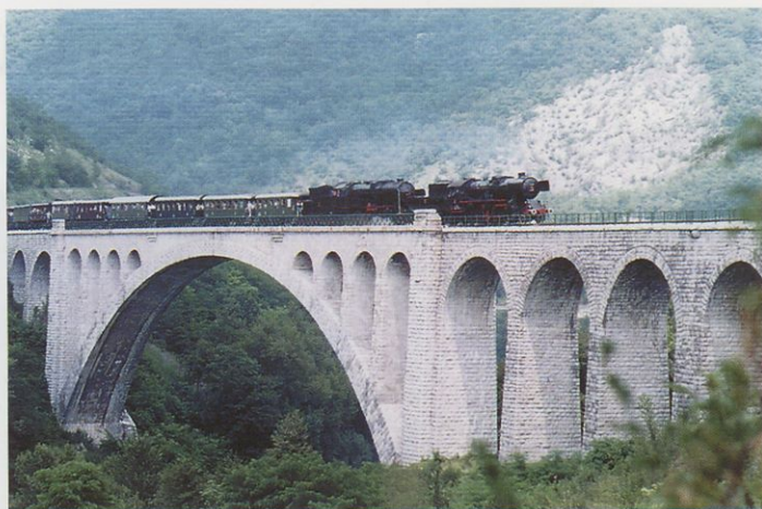
Muzejski vlak med vožnjo čez solkansko znamenitost, železniški most, ki je bil ob nastanku leta 1906 most z največjim kamnitim lokom v Evropi. Njegov lok se razpenja nad strugo reke Soče v razdalji 85 metrov.
