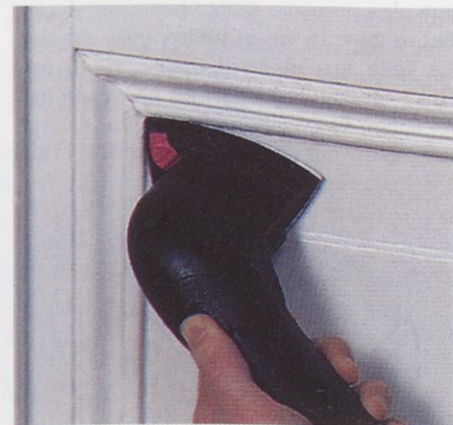
Slika 11. Delta brusilnik je zelo uporabno orodje pri prenavljanju oken, starih omar ...
