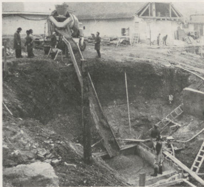
Prvi kubik betona za novo upravno zgradbo
