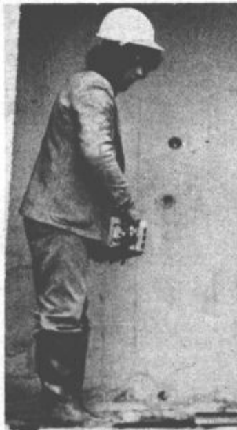
Delavci, ki so opravili strokovni izpit, vedo, da mora biti zaščitna ograja visoka en meter
