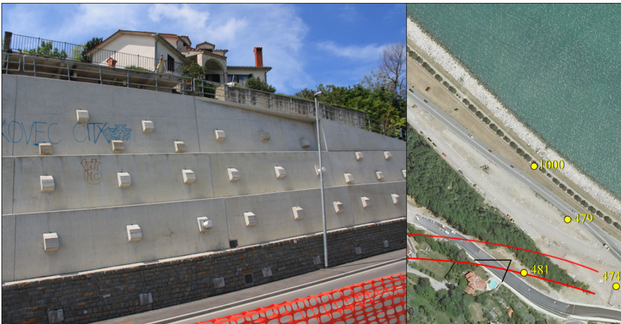
Slika 41: Obravnavani objekti in stabilizirani stebri v sektorju 1. Samo okoli 25 % celotnega podpornega zidu je vidnega na sliki, ki sicer v dolžino meri okoli 130 m, v višino pa 10 m. Črni črti na desni sliki označujeta zorno polje leve slike.
