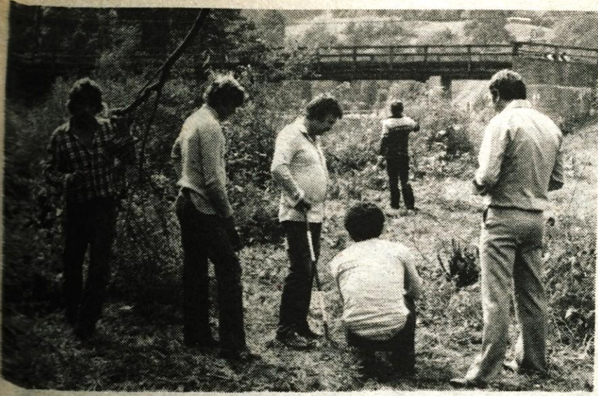
V začetku tedna so se začela pripravljala dela pri gradnji novega mostu na Trebji. Poleg ozke ceste med Fužinami in Selom je ta most ena največjih zaprek pri prometu za Žiri. Konejnerski promet morajo preusmerjati prek Logatca in Rovt, kar prinaša žirovskemu gospodarstvu večje stroške. — Foto: F. Perdan
