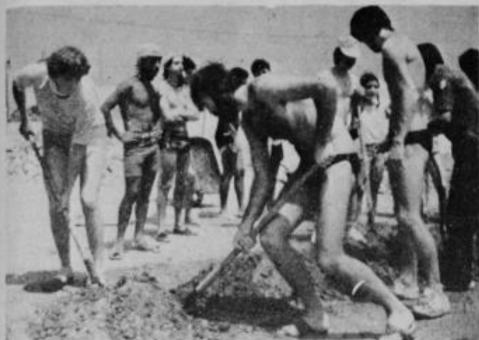
Branko Weinmüller na delovišču med mešanjem betona.
