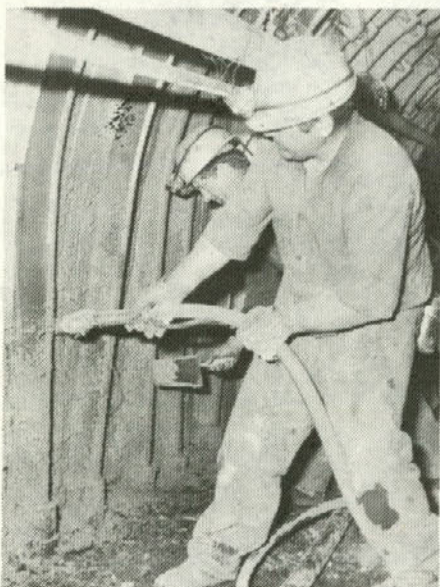
Strojno ometavanje izolacijske obloge v jamski progi.
