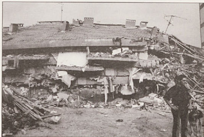
Dobesedno sesedena štirinadstropna stavba.
