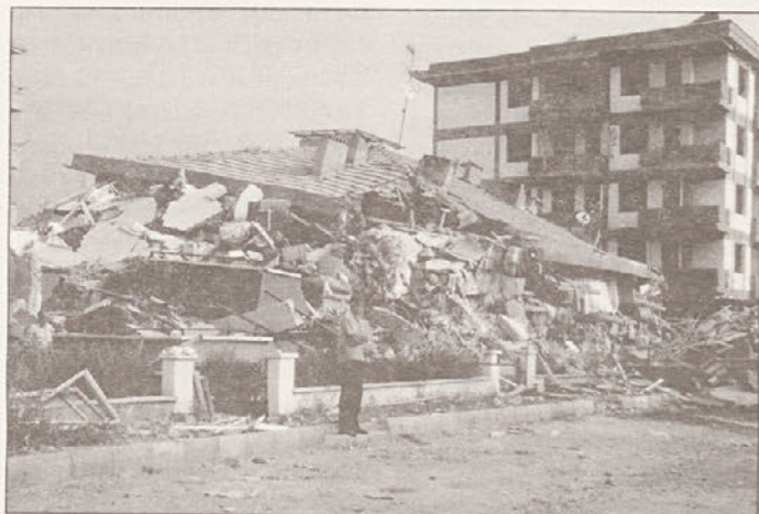
Marsikatero hišo je porušilo do tal. V ozadju pa je skoraj nepoškodovan blok.
