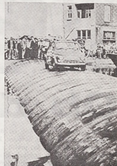
Izvedba polnjenja gumenega jez pri Vredensteinu. Malj Fiat naj bi ponazoril trdnost jez.
