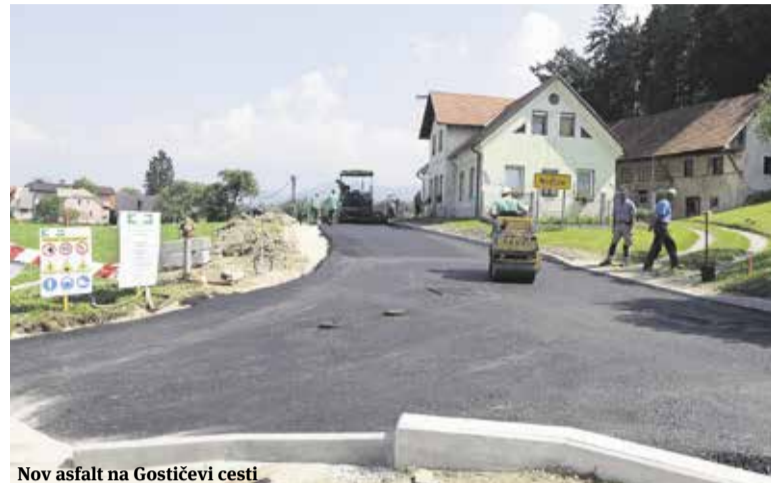
Nov asfalt na Gostičevi cesti
