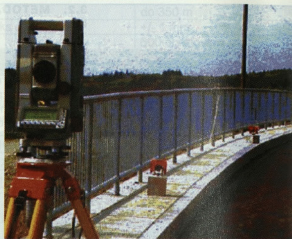
Slika 5: Postavitev geodetskih prizm
