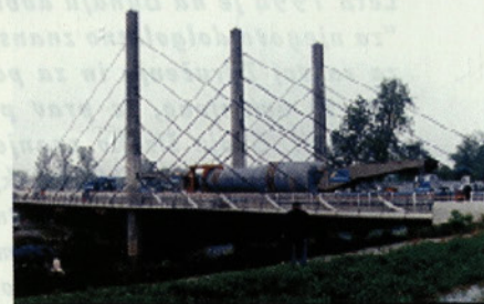
Meritve deformacij med prevozom uparjalnika za JE Krško
