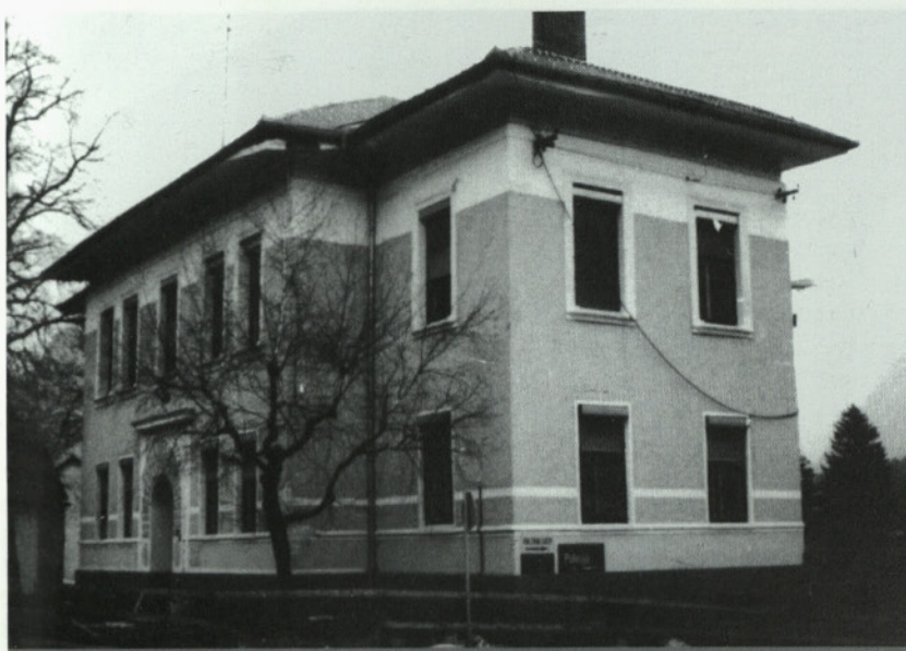
Slika 2: Policijska postaja Bovec (stavba C) - primer javne stavbe
