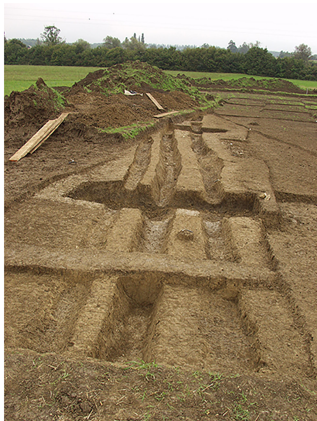
55 Pogled na drenažne jarke v sektorju F.
