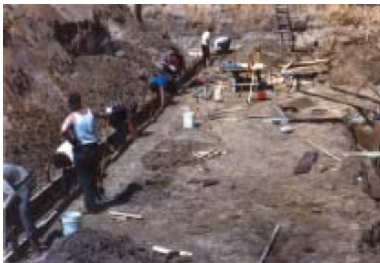
Gradnja temeljev novega društvenega doma
