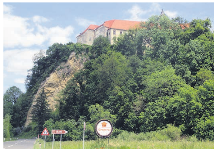
Sanacija brežine pod Borlom bo zaradi višine, strmine in oteženega dostopa (v grad od leta 2010 zaradi nevarnosti ni mogoče vstopiti) tehnično izjemno zahtevna.
