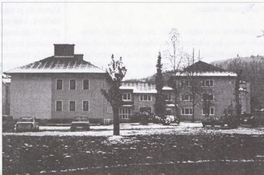
Občinska stavba na Čečovju je pred dnevi dobila »novo barvo«
