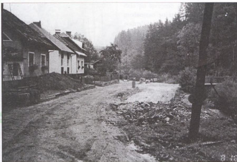
Gradnja ceste Čečovje - Žaga
