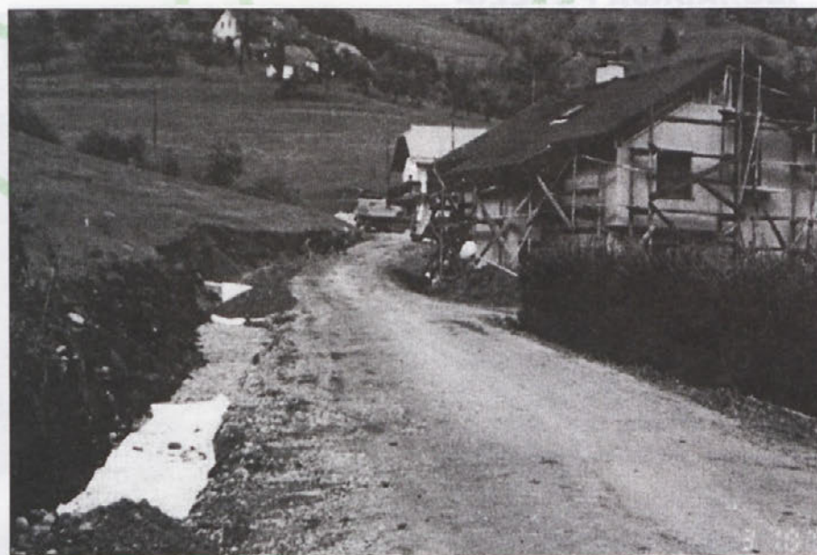
Gradnja ceste Tolsti vrh
