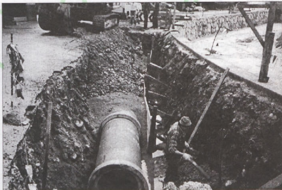
Izgradnja kanala »L«
