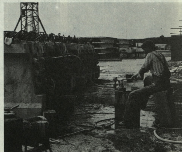
Slika 1, 2. Nosilci na deponiji v tovarni TOGREL
