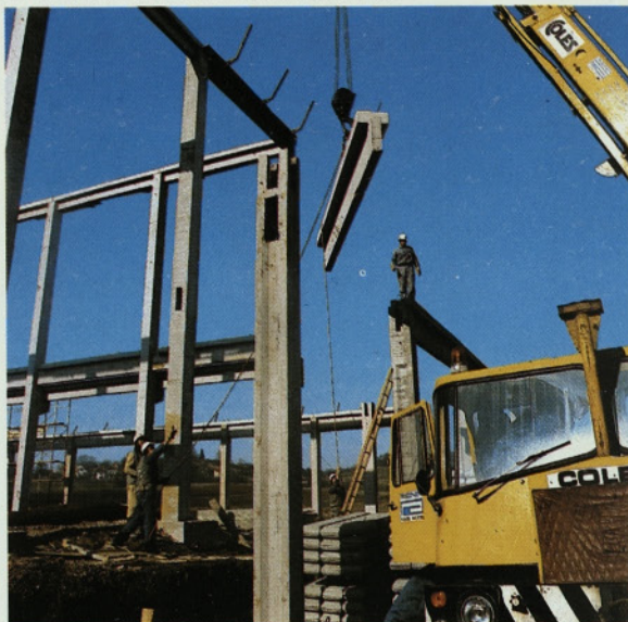
GRADNJA INDUSTRIJSKE HALE
