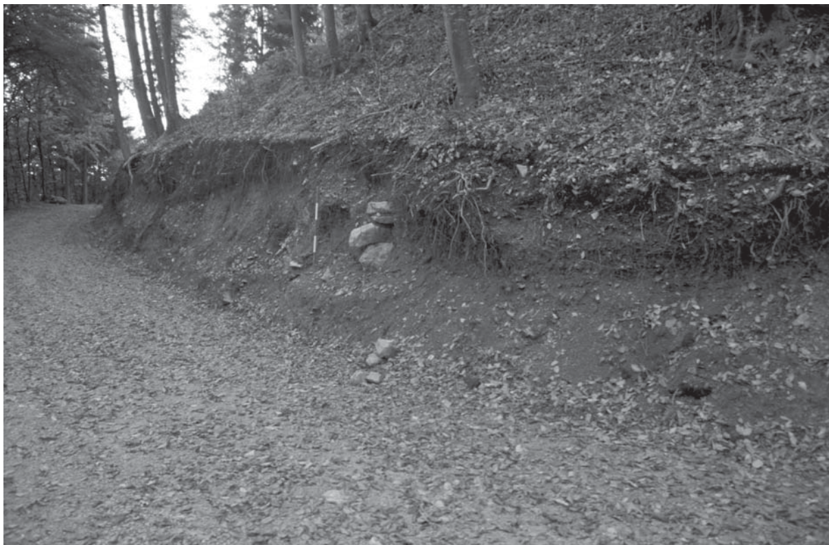
Sl. 36: Kostjavec nad Tihabojem. Vsek za cesto na severovzhodnem pobočju vrha.
