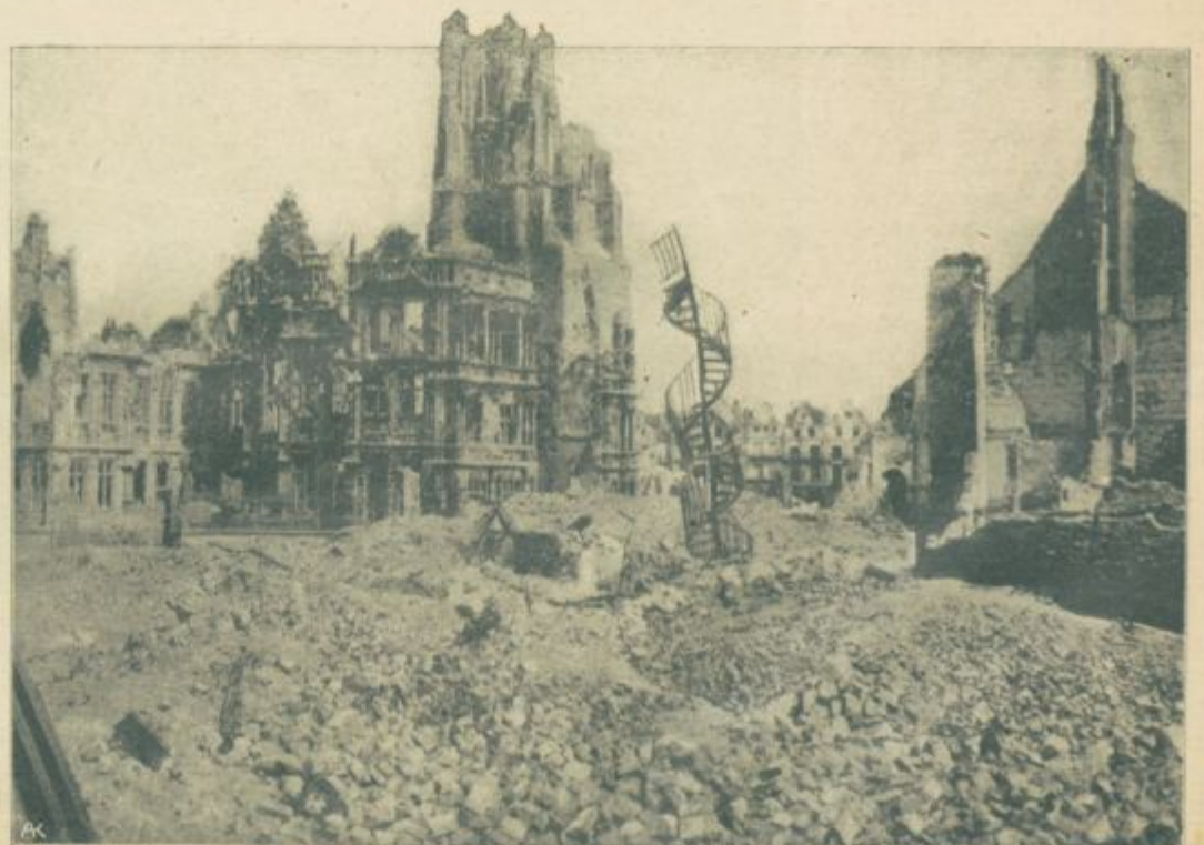
K bojem na belgijsko-francoski fronti. Razvaline mestne hiše v Arrasu. Popolnoma porušeno pročelje; ohranjene so le stopnice, ki so vodile z dvorišča v nadstropje.
