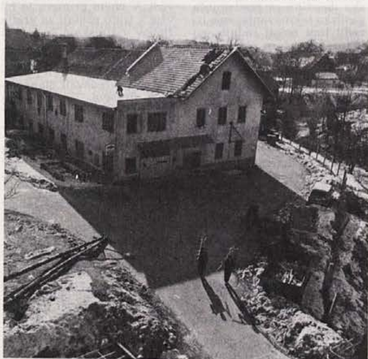
Elanova zgradba po ustanovitvi — s prvim prizidkom 1947
