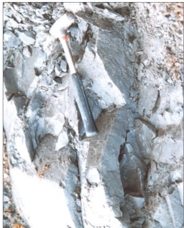
Sl. 7. Nabrekanje in odpiranje razpok v sivici zaradi gradienta sukacije, avtocestni vkop pri Vranskem v letih 1996–1997, sveže odkopana brežina. Predhodne geološke raziskave niso opozorile na možnost nabrekanja.
