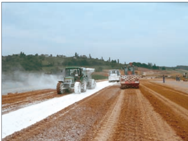
Sl. 15. Posnetek iz časa gradnje avtocestnih nasipov iz nabreklih glin na odseku Cogetinci - Vučja vas.
