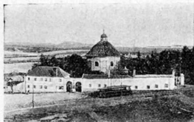
VHOD NA CENTRALNO POKOPALIŠČE
