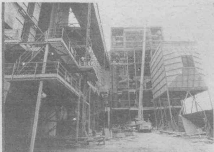
Gradnja 2. faze toplotarne je v polnem teku. Če bo šlo vse po načrtih, naj bi proti koncu letošnjega leta že stekla poskusna proizvodnja. Na sliki: parni kotel z zmogljivostjo 270 ton na uro, pare parametrov 115 barov in temperature 535°C.
