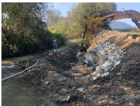
Dela na transportnem cevovodu za bogatenje vodotoka Trnavca (Foto: M. Jager)
