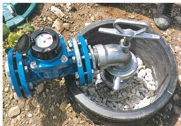
Novi hidrantni glave in števec porabe vode na namakalnem sistemu Gotovlje (Foto: M. Jager)
