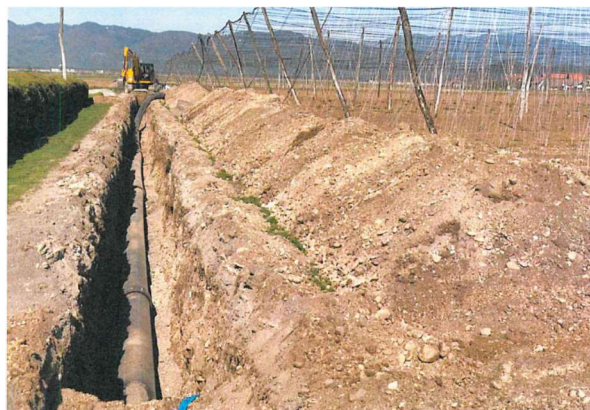
Polaganje novega primarnega cevovoda na namakalnem sistemu Breg (Foto: M. Jager)
