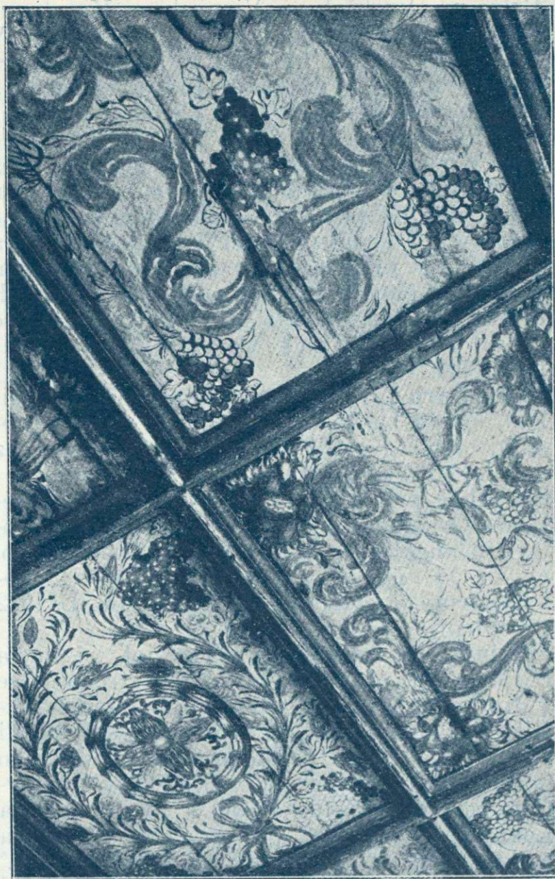
STRAŽNI VRH: LESENI STROP, DETAJL (ZAČETEK XVIII. STOL.).
