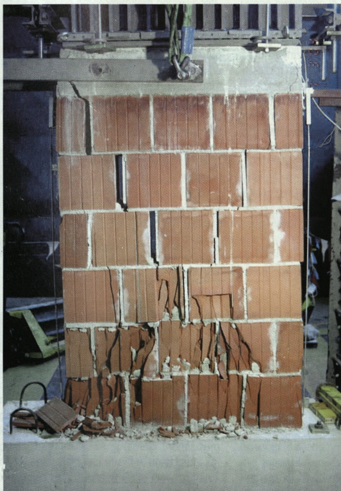
Slika 11 • Krhka lokalna porušitev votlakov pri strižni porušitvi zidov tipa BN
