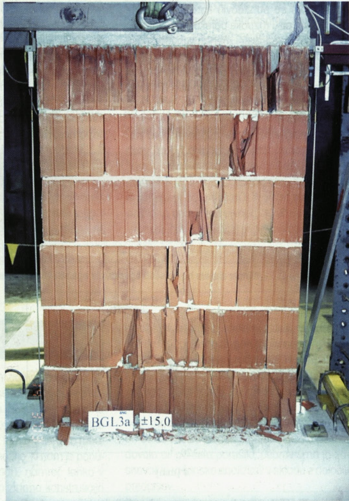
Slika 12 • Krhka lokalna porušitev votlakov pri strižni porušitvi zidov tipa BG
