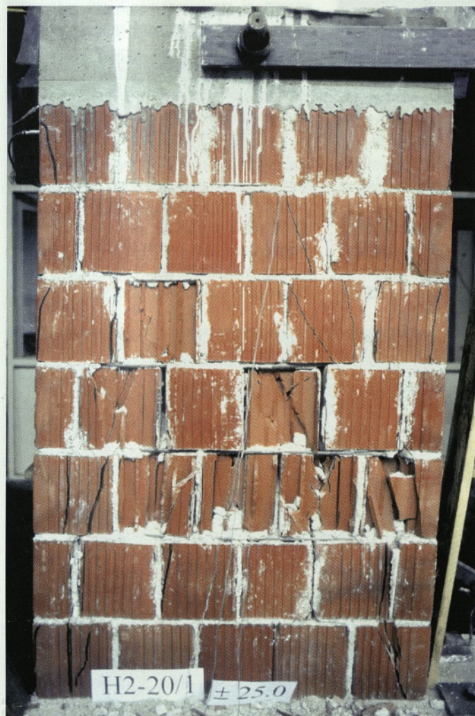
Slika 7 • Poškodbe votlakov v osrednjem delu armiranega zidu pri poružitvi
