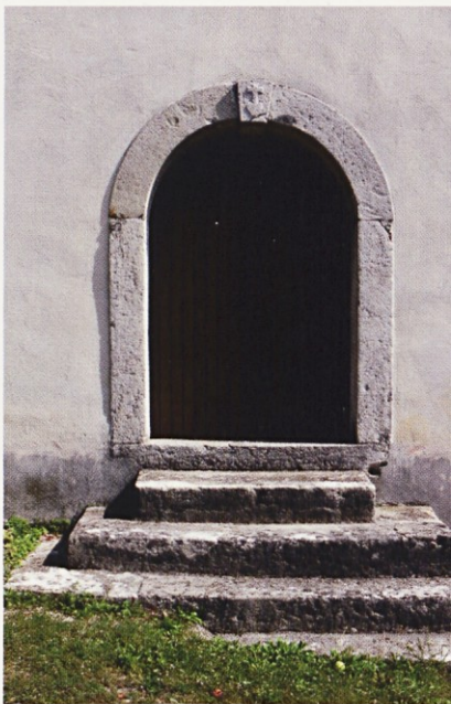
Zahodni portal vhodne lope iz leta 1726.
