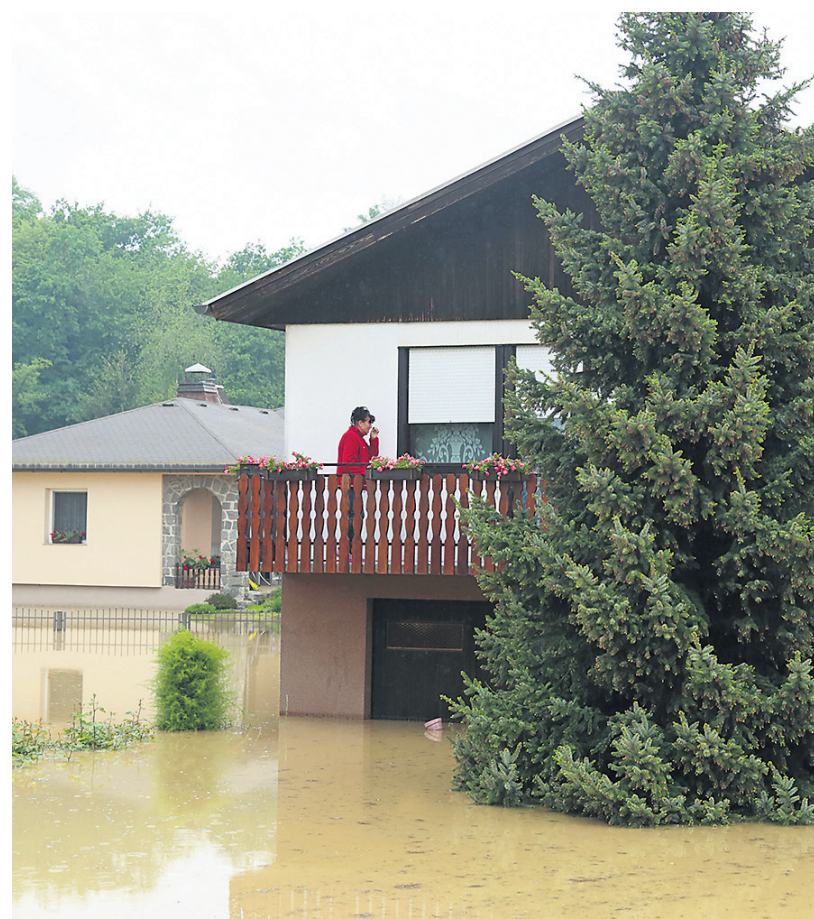
Zaradi ogromnih količin dežja se je padavinska voda po pobočjih gričev stekala tokov in se nato razlivala po bližnji okolici, čez ceste, v objekte ... Fotografija je iz
