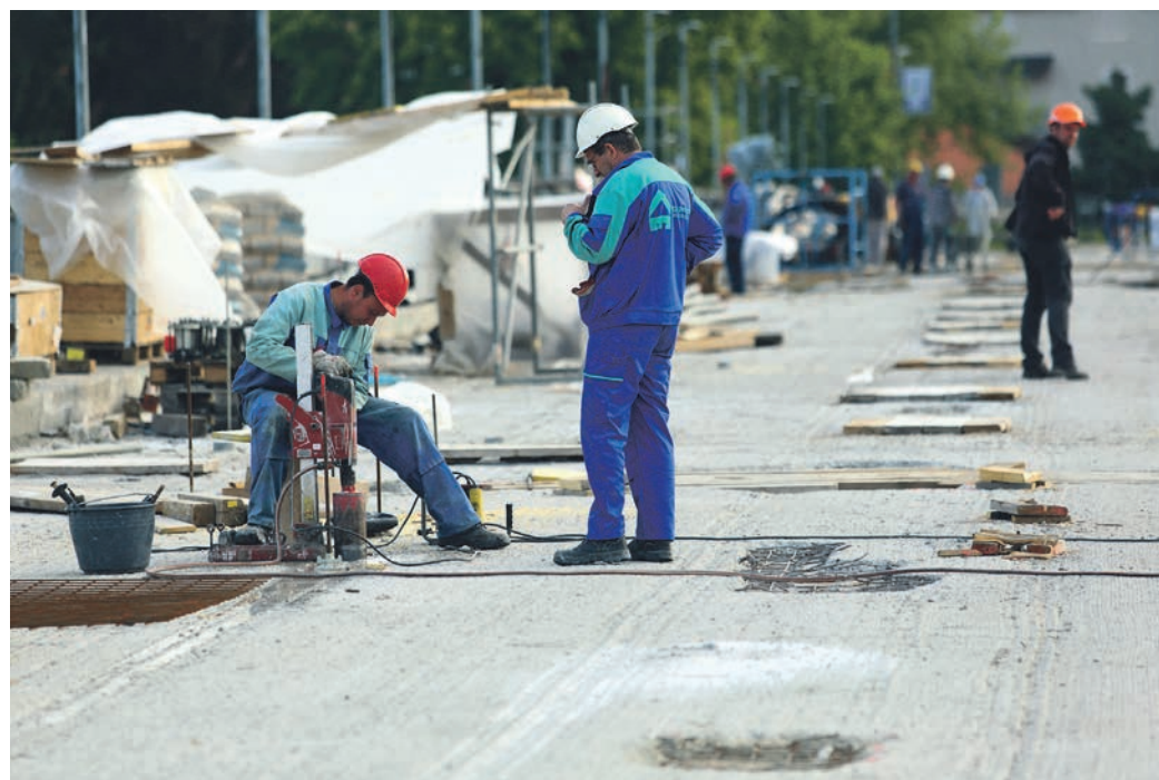
Dela na mostu se izvajajo v 140 prekatih, vse v notranjosti objekta. Foto: Črtomir Goznik
