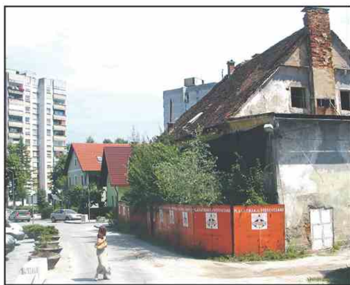
Mayerholdova hiša je že dolgo ne le sramota, ampak prava nevarnost v mestu. Končno jo bodo lahko porušili.
