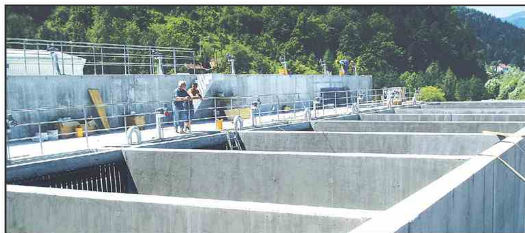
Beton, beton ... V objekte CČN ga je vgrajenega okoli 3.000 kubikov.
