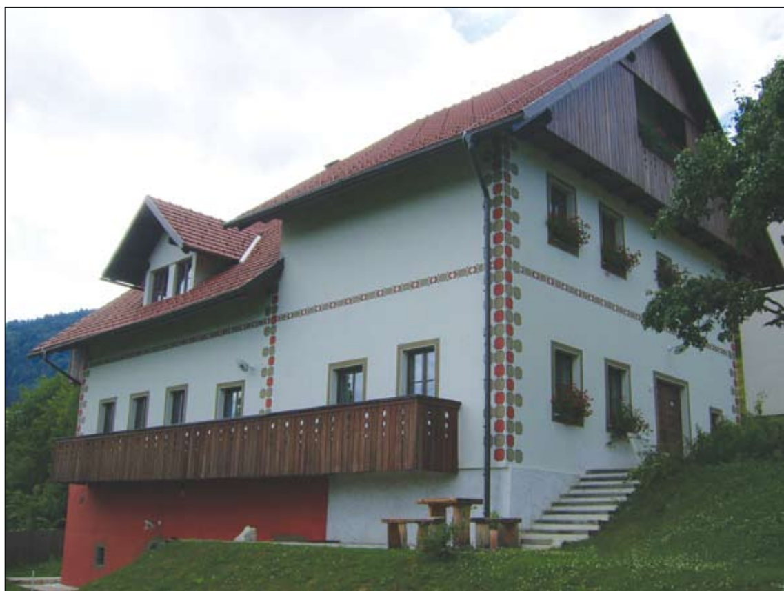
Prenovljena rojstna hiša slikarja Antona Ažbeta v naselju Dolenčice pri Poljanah nad Škofjo Loko (arhitekturna prenova: Meta Peternelj Mohorič, likovna prenova stavbne zunanosti: dr. Živa Deu)
