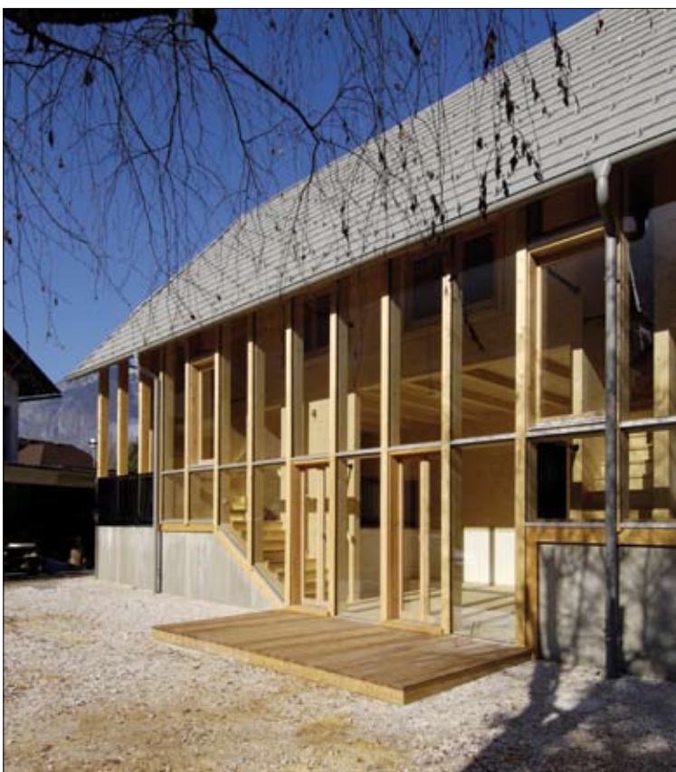
Hiša v Čezsoči (2004) se odlikuje po leseni nosilni konstrukciji in posameznih detajlih, ki povzemajo oblikovne prvine »bovske« hiše. Avtorja projekta sta Matej Blenkuš in Miloš Florjančič (A Biro). (Foto: Miran Kambič)
