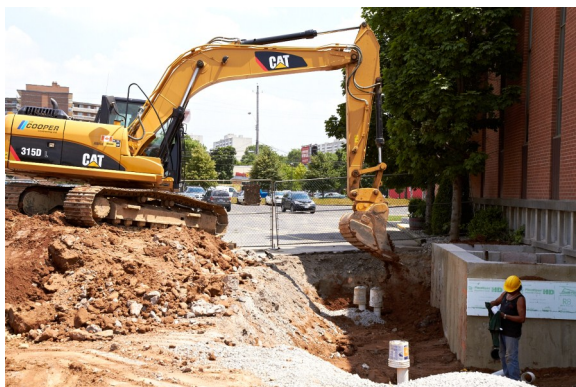
GRADNJA TEMELJEV za dvigalo in strojnico. Zamenjali smo tudi stare kanalizacijske cevi z novimi plastičnimi. Sedaj pa je že vse nazaj zasuto.
