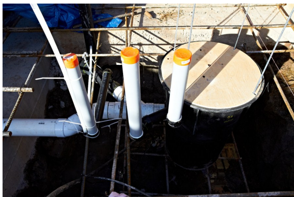
GRADNJA TEMELJEV za dvigalo in strojnico. Zamenjali smo tudi stare kanalizacijske cevi z novimi plastičnimi. Sedaj pa je že vse nazaj zasuto.
