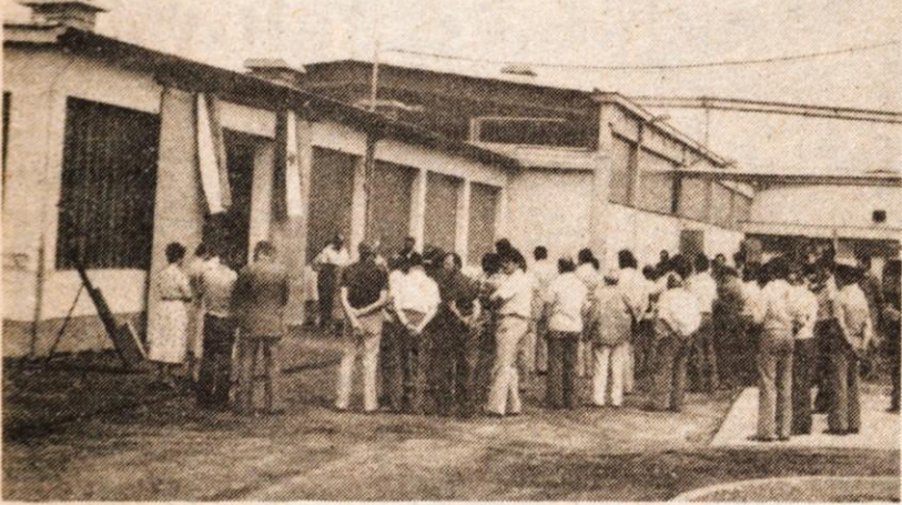
Med novimi proizvodnimi prostori, ki so jih odprli ob kamniškem občinskem prazniku, je tudi delavnica s skladiščem in kotlovnico v Stolovi TOZD Sloga v Mostah. — M. V.
