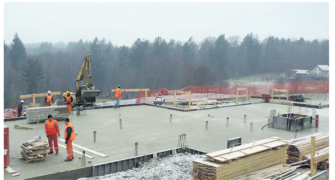
Gradnja medgeneracijskega centra poteka s polno paro.
