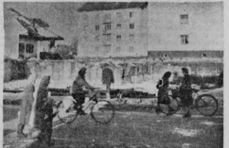
Slika prikazuje temelje porušene zgradbe z jamo na Ptujski cesti, kjer se poleg vodovodnih cevi kopičijo smeti. Ali bi ne kazalo na tem prostoru nadaljevati z gradnjo stanovanjskih objektov?
