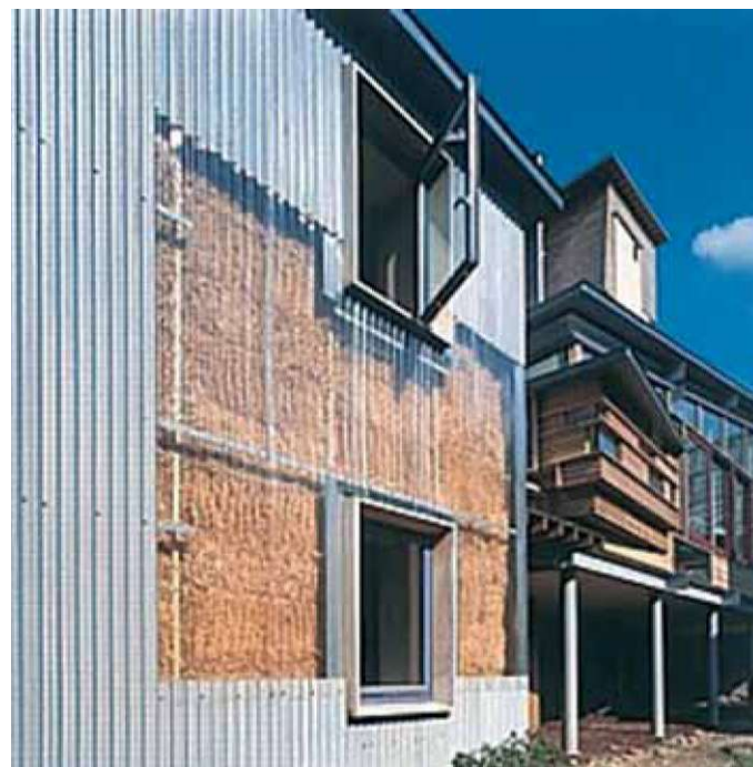
Slika 5: Stanovanjski objekt v Londonu. [vir: http://www.swarch.co.uk/].
