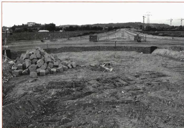
Gradbišče na povezovalni cesti.
