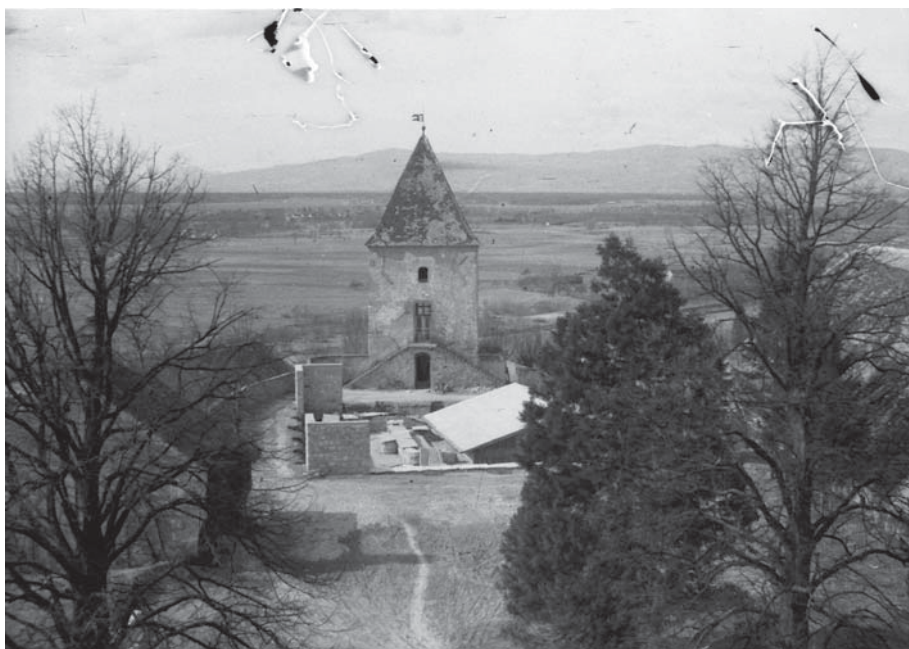
Slika 8: »Svetišče,« pokrto s streho, in nosilne stene za »širšo« zaščitno streho. 204 Roofed „Temple“ and load-bearing walls for a „wider“ protective roof.
