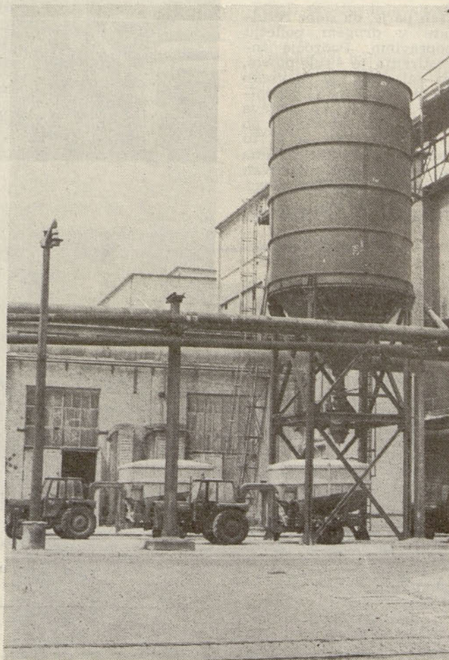
Novi silos za glinico
