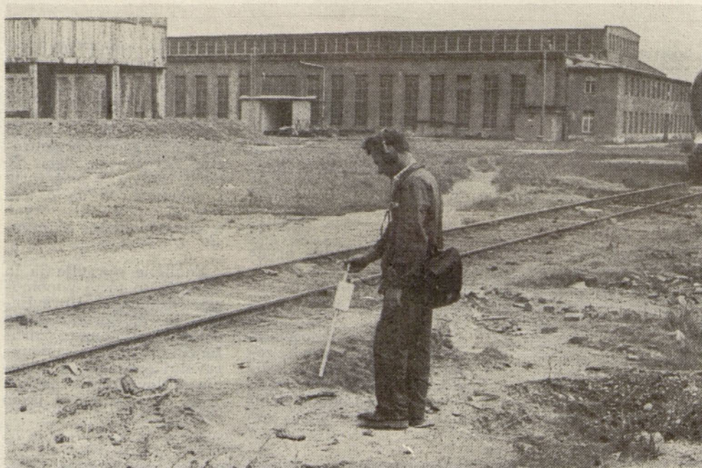
Iskanje telefonskega kabla
