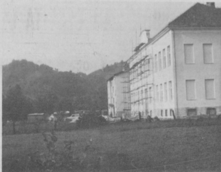
Šolska stavba med obnovo
