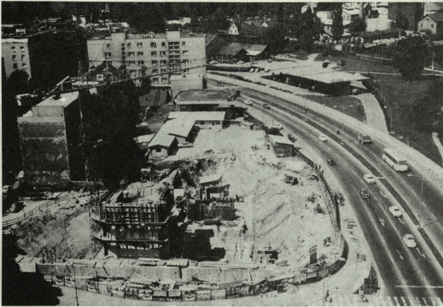
Sl. 8. Gradbena jama stolpnice Bavorski dvor v Ljubljani
