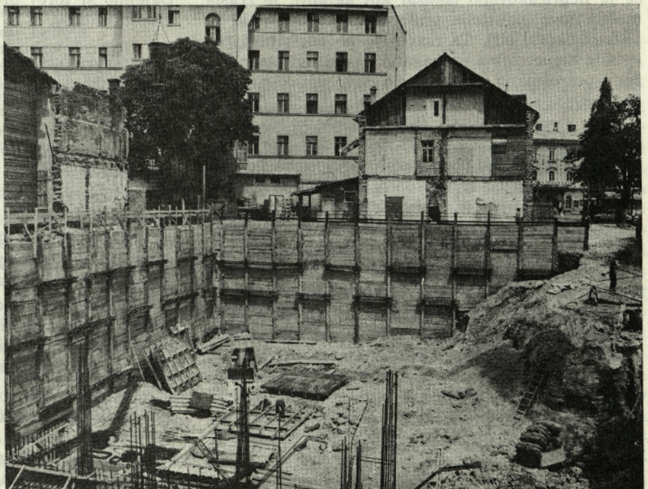
Sl. 11. Zaščitna stena gradbene jame poslovne zgradbe pri kolodvoru v Ljubljani
