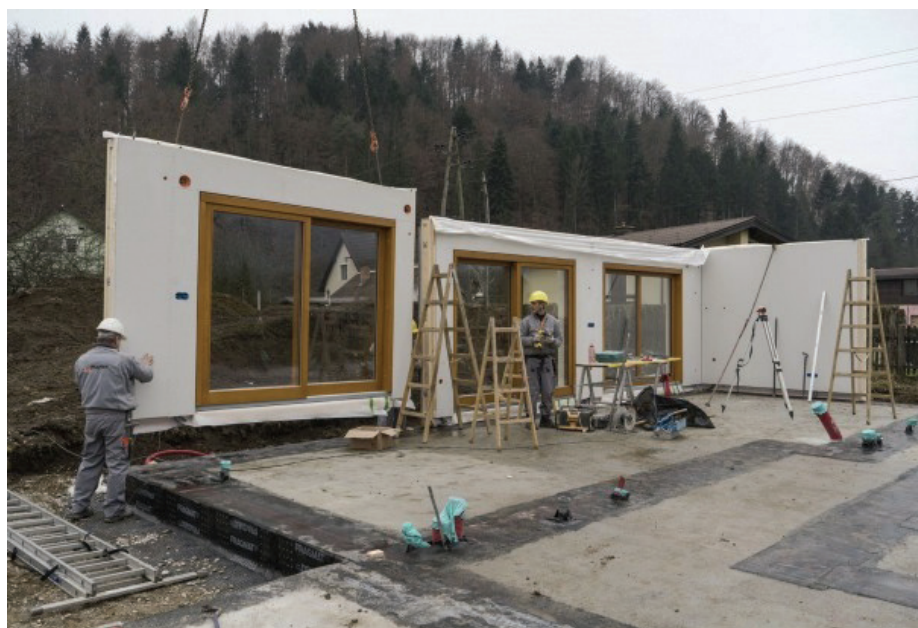
Slika 2 • Montaža stenskih panelov (Marles, 2019).
