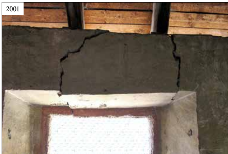
Statična sanacija stavbe je odpravila tudi nekatere resnejše probleme.
