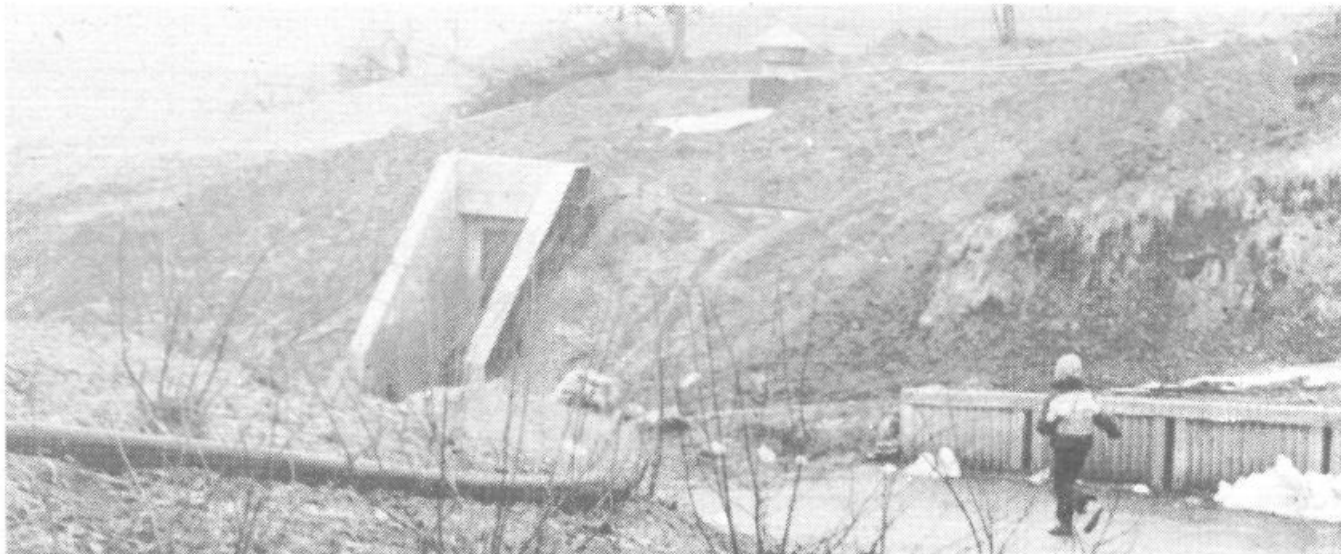
Trenutno motiv za fotografa ni posebno zanimiv. Betonski vhod, zračnik, sveže nasuta zemlja. Za vse to pa je bilo nekaj sto ur delovnih Dobrovčanov oktobra in novembra lani. Izgradnja črpalne postaje s 15 kubičnim rezervovarjem pa je predzadnja stopnja pri dokončni ureditvi oskrbovanja Dobrove z vodo
