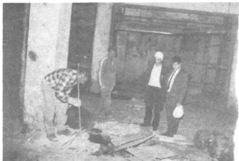
Na zgornji sliki: Dvigalo je premaknilo sušilni valj. Spodaj: D. Kolšek in F. Černelič pri temelju, ki ga bodo zminirali.
