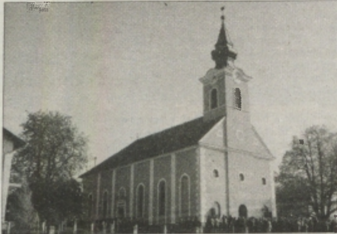
Pogled na evangeličansko cerkev v Križevcih v Prekmurju. Temelje zanjo so postavili v daljnem 1783. letu, pozneje pa zgradili prizidke in še cerkveni stolp. Cerkev je vzorno vzdrževana.
