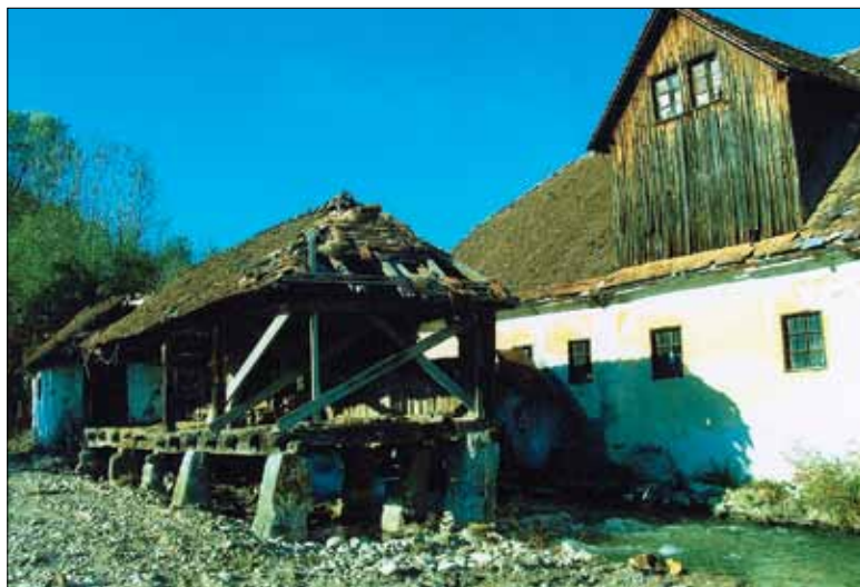
Slika 2: Značilna dvonadstropna zasnova je vidna na opuščeni venecijanki v Radomljah pri Domžalah.
