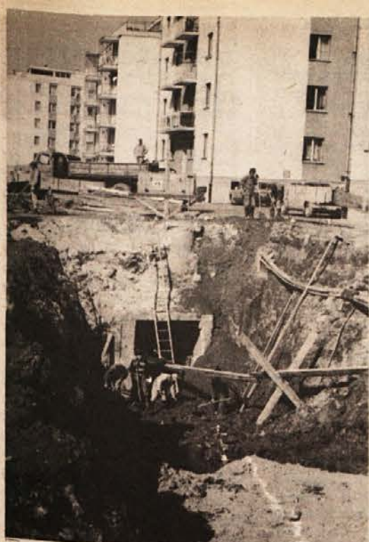
PODALJŠEK KANALIZACIJE – Ob Zagrebški cesti v Novem mestu gradbeno podjetje Gradis iz Ljubljane pripravlja veliko gradbeno jamo kot podaljšek do tu že zgrajene kanalizacije za potrebe Industrije motornih vozil. (Foto: J. Pavlin)
