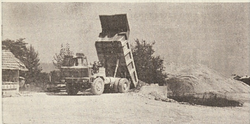
Na separaciji je dela vedno dovolj, saj je treba preskrbeti vsa ljubljanska gradbišča oziroma betonarne
